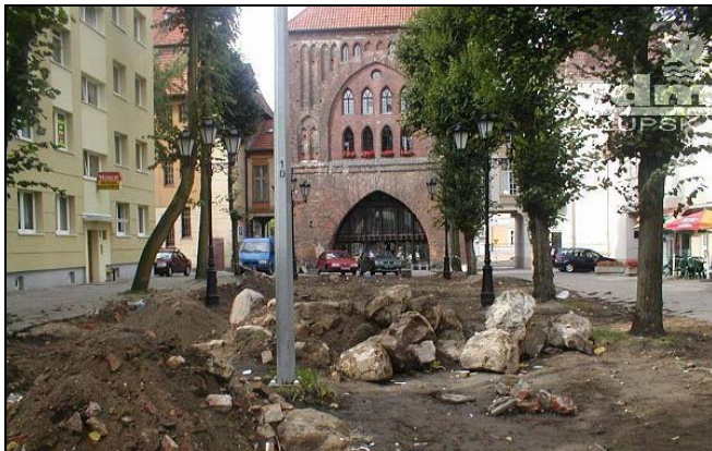
ul. Nowobramska przed modernizacją
