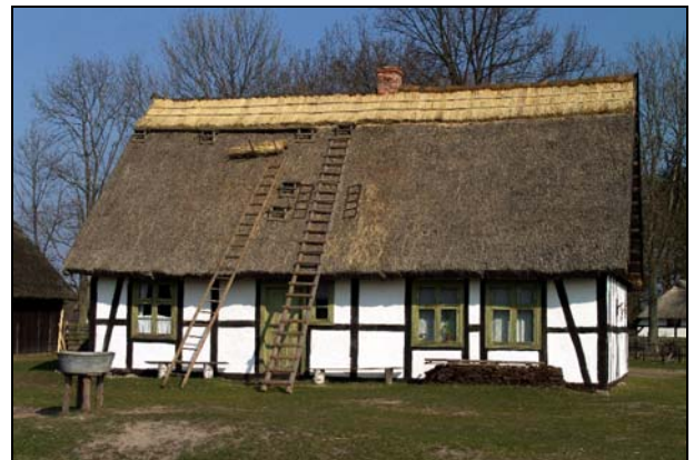
Chałupa Alberta Klücka. Naprawa dachu. fot. B. Arszyński
